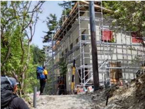
工事中の湯俣山荘
