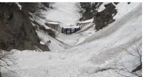
鋼製スリット、H鋼の蓋が役に立った
